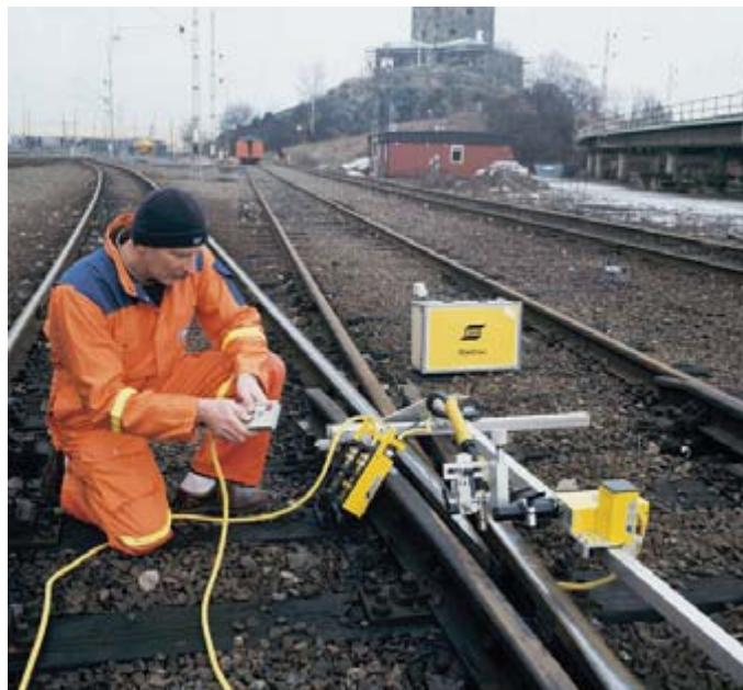
**Railtrac BV1000/BVR1000** (Рейлтрак БВ1000/БВР1000) — это автоматические установки для эффективного механизированного ремонта и твердо-сплавной наплавки ж/д рельсов. Один оператор может легко и быстро собрать, запрограммировать и управлять работой оборудования. Обучить оператора пользоваться установкой исключительно просто и быстро.
